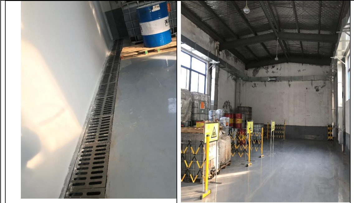
危废库 环氧地坪、排风设施、分区放置、警示牌、照明
