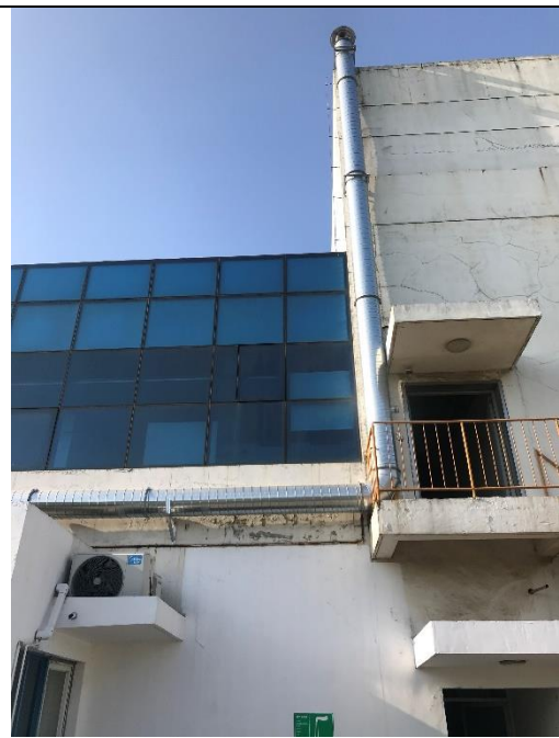
食堂油烟排气筒
