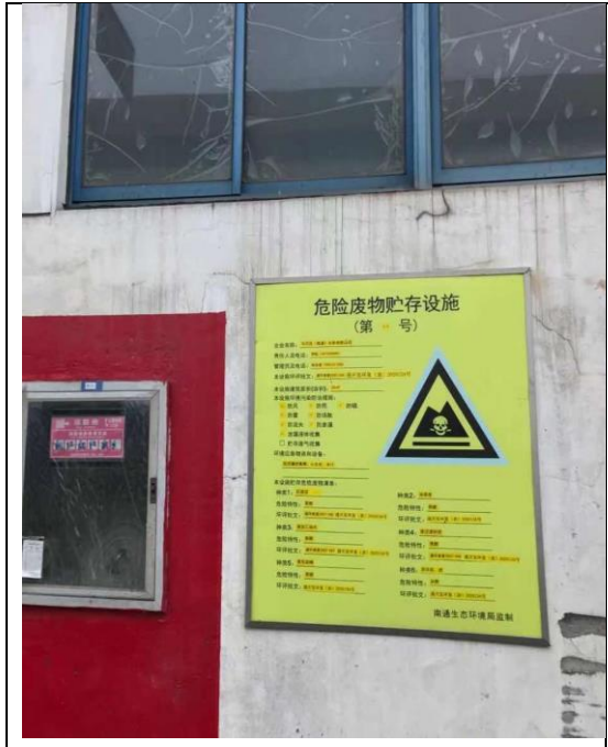
环保标识牌、消防栓
