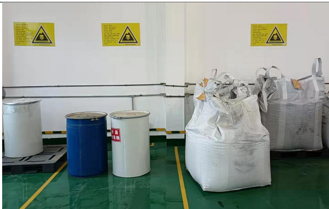
环氧地坪、危废分区密闭储存
