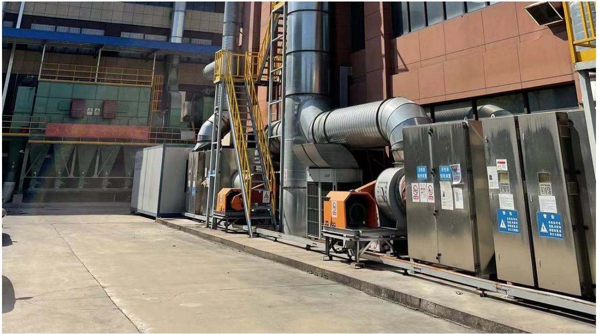
图4.1-4 高效滤筒除尘器装置
